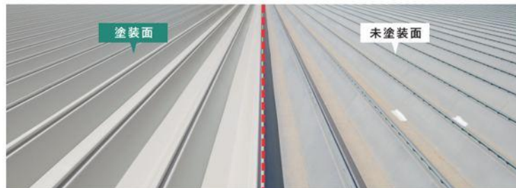
超低汚染リファイン500Si-IR塗装面と未塗装面それぞれの屋根表面、屋根裏面をサーモグラフィーで撮影。また、温度記録計を設置し、1日の温度変化を測定しました。
